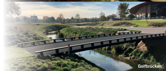
Verkehrsbrücken und Brückendecken
